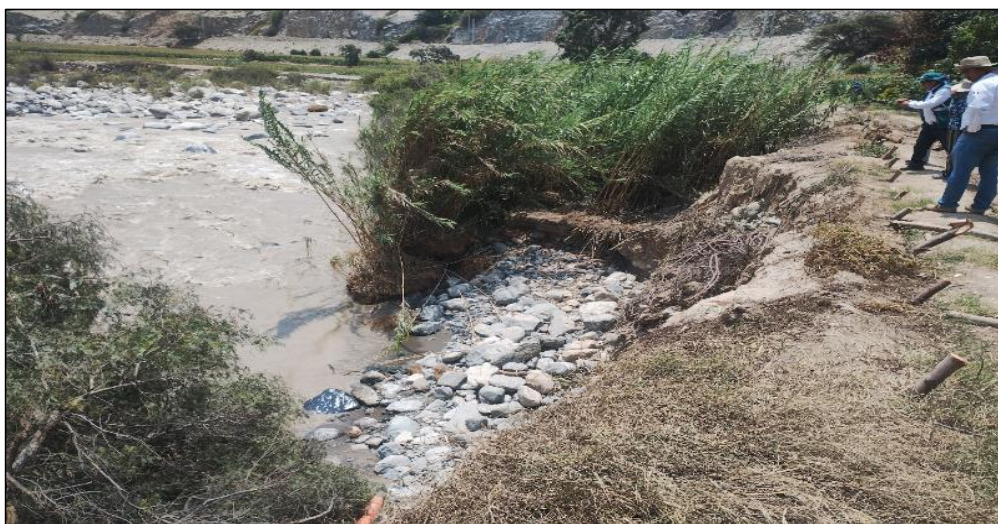
FIGURA N°02: INFRAESTRUCTURA HIDRAULICA COLAPSADA ANTE UNA CRECIDA DEL RÍO PISCO EN LA MARGEN DERECHA
